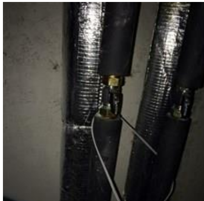
Bild 2 Avstängningsventiler
